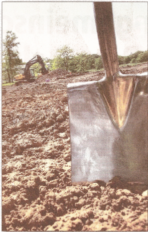
Auf der Dilldorfer Höhe fand der Spatenstich für die erste Klimaschutzsiedlung in Essen statt.
