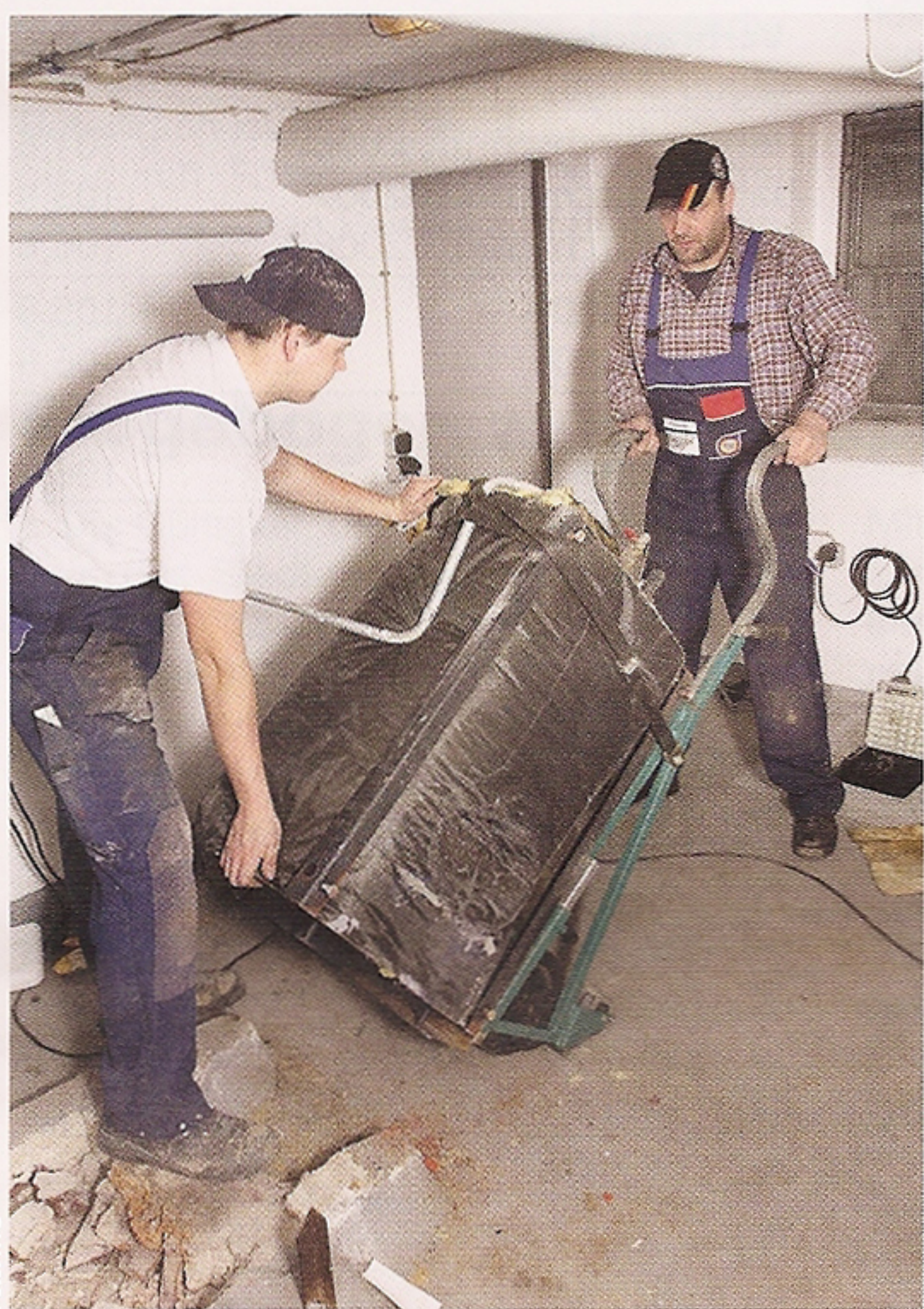
Wer Reparaturen zeitlich steuert, profitiert vom Werbungskostenabzug.
