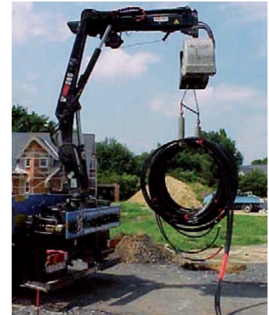
[Bild 13] Sondenrohr vor dem Einbau
