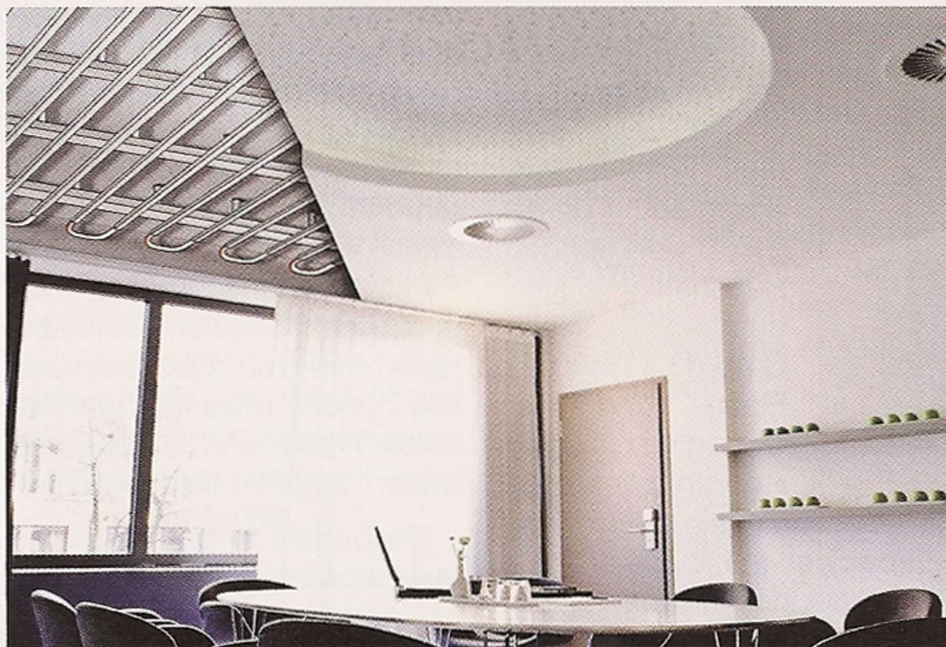
Der Gestaltung von Klimadecken sind dank moderner hoch wärmeleitfähiger Trockenbauplatten keine Grenzen gesetzt.
